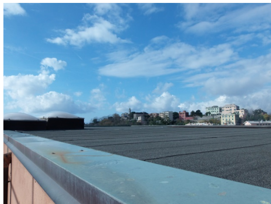
Figura 8.3 - Particolare copertura piana su cui intervenire.
