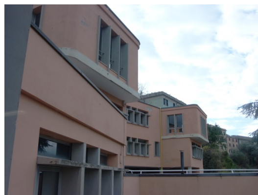
Figura 1.1 - Vista della facciata esposta a nord ovest
